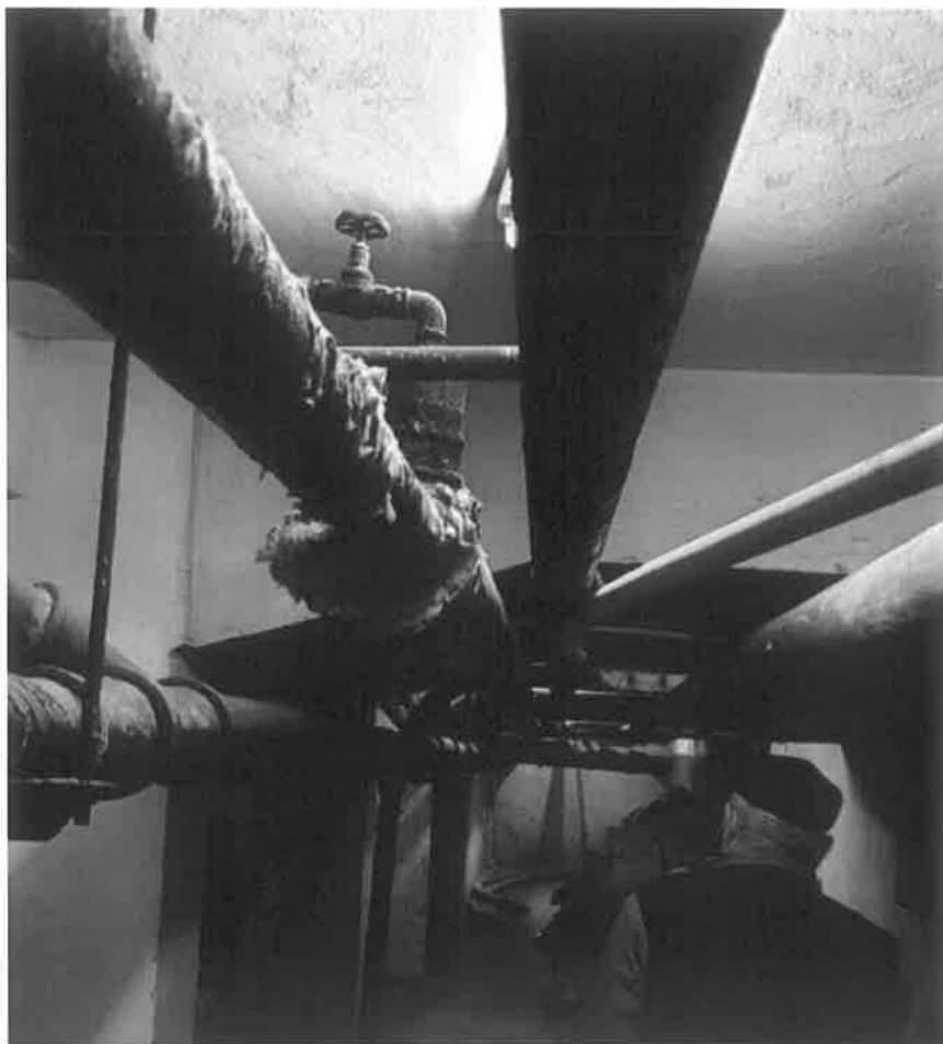
Foto 7 – Vedere interioara demisol (se observa ca grinda transversala are sectiune variabila la capete)
