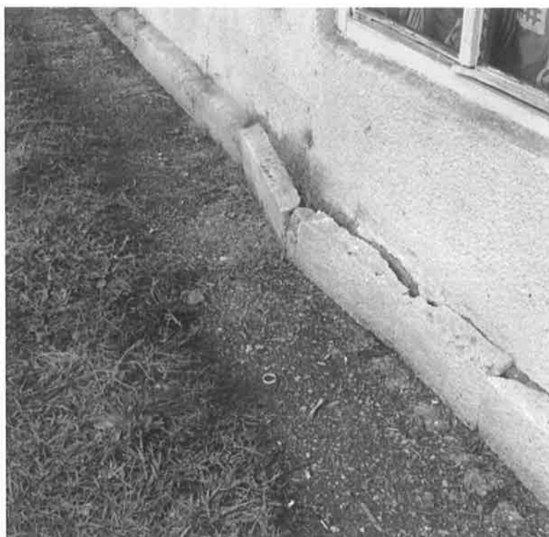
Foto 14 – Fatada sudica-se observa degradarea/dislocuirea soclului existent
