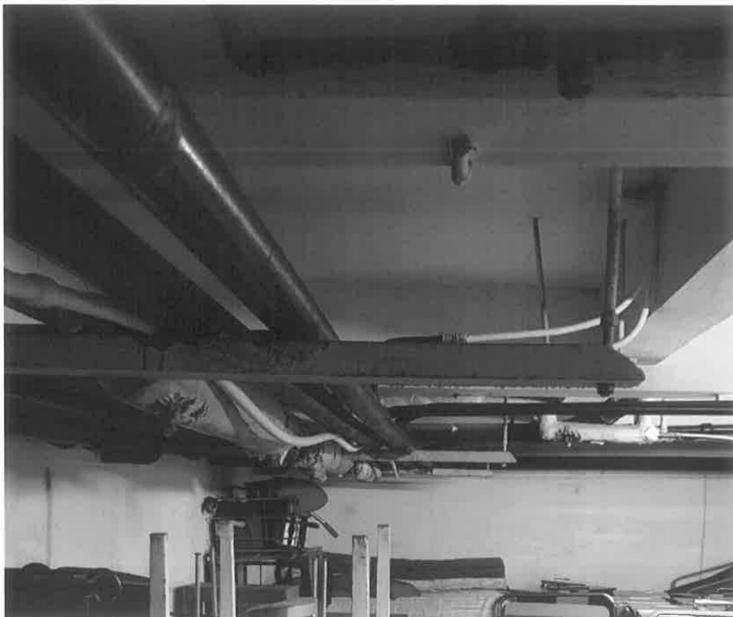
Foto 9 – Vedere interioara demisol (se observa grinda secundara pe care reazema peretii de compartimentare din etajele superioare)
